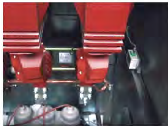
无线温度接收器安装时应靠表带式发射器安装，以保证通讯效果
